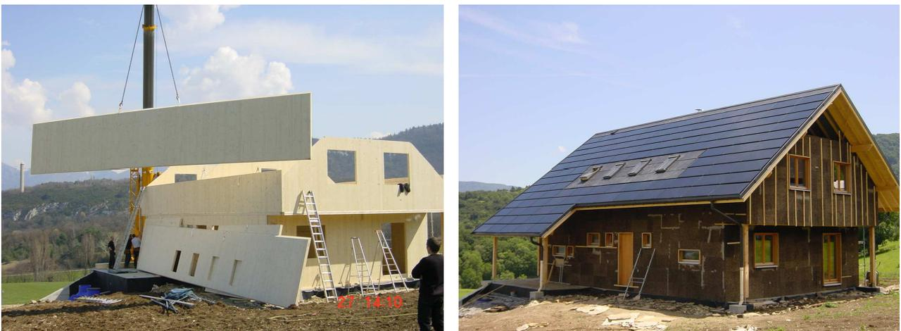
Figure 1 : La pose du KLH et la pose de l'isolation liège (face NORD-OUEST)
