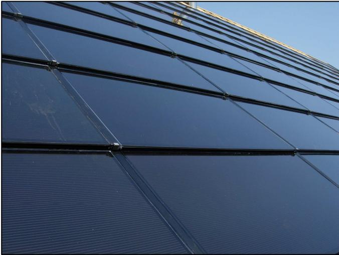
Bien qu'affichant de plus faibles rendements que les technologies multi ou mono-cristallines (7%), ils ont le mérite d'être bien moins coûteux au m<sup>2</sup>. L'association de ces deux caractéristiques fait de cette technologie un candidat idéal à la substitution de tuiles ou d'ardoises car le différentiel d'investissement est rapidement comblé par la revente de l'électricité produite par le toit. Dans notre cas, cela représente une rente annuelle de 6 000€.
