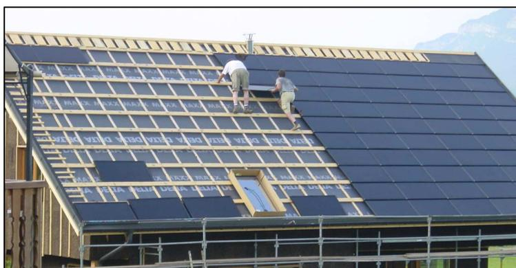
Nous avons installé sur la maison ZEN une puissance photovoltaïque de 13,5 kWc qui produira annuellement environ 12 000 kWh. Les modules, couplés avec un système d'intégration remplacent les éléments classiques de toiture. Ainsi, l'ambition de ce projet est de faire la promotion et la pédagogie de l'utilisation de l'énergie photovoltaïque, qui quand elle est pensée dès la conception d'un projet s'avère pertinente à la fois techniquement, financièrement et esthétiquement.
